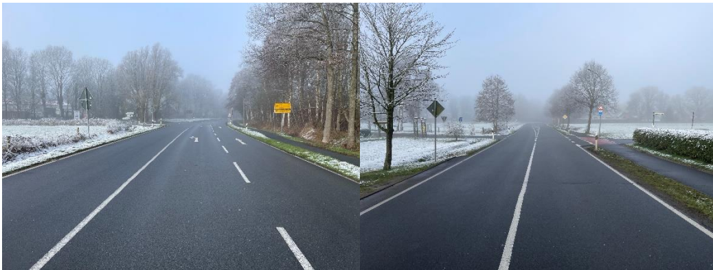
Abbildung 3: Leeraner Straße (L 821)
